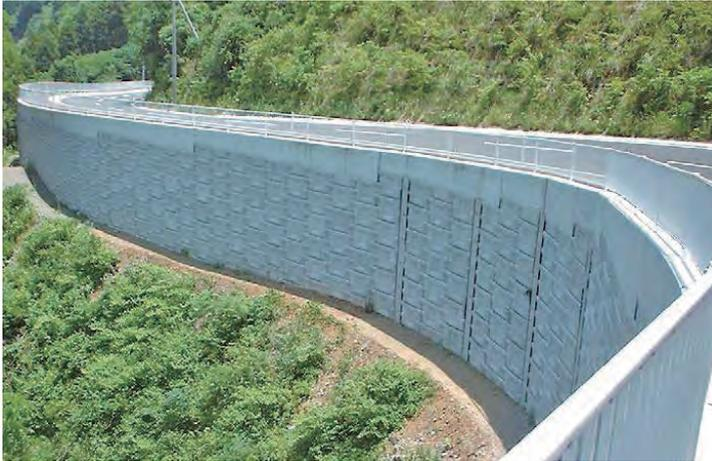
多数アンカー式補強土壁工法は、1970年に旧建設省土木研究所にて考案された「杭張材を用いた盛土安定増大工法」を原案とするわが国独自開発の補強土壁工法です。特徴としては、下記6項目です。
