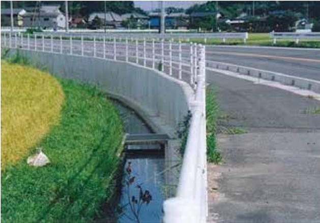
道路用地を100%利用できる直壁のL型擁壁です。設計外力に対応した形状設定による力学的構成を呈し、経済性・施工性に優れた軽量構造の道路用L型擁壁です。
