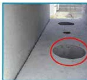
● 底板に開孔を設けることにより、インバートコンクリートの一体性向上や底部浸透利用が可能
