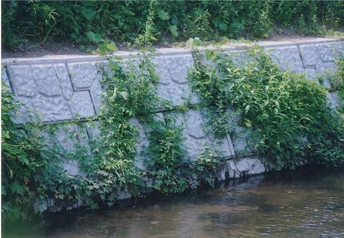
ビオグリーンは、環境保全型ブロック・中空型に属し、緑化復元に最適な護岸NETIS登録製品です。急傾斜用の護岸ブロック・大型積みブロックで、魚巣ブロック用・玉石積み用・高さ調整用・R曲線施工用タイプもあります。目地から植生できる構造で、河川改修工事・災害復旧工事・集落農道整備工事・親水水路整備工事などに採用されています。土木研究センターの護岸ブロックの水理特性値証明書を取得しています。
