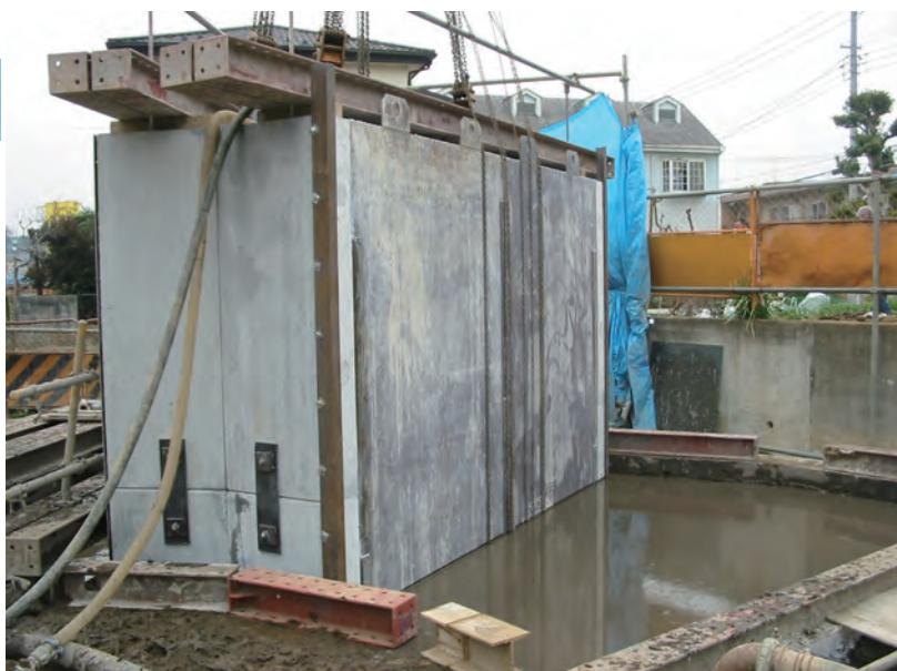
沈埋工法は、スペシャルスラリー（自硬性安定液）又はペントナイト安定液を壁面安定液としてトレーニチを掘削し、一定の長さにあらかじめ連結したボックスカルバート・もしくは単体のボックスカルバートをトレーニチの中に沈め所定位置に吊金具で固定し、スラリーを固化する事によって工事完了とする簡便で画期的な函埋設工法です。
