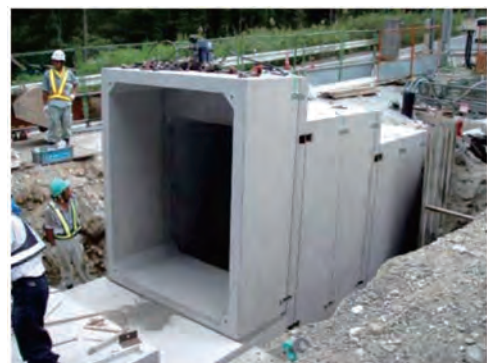
断面変化部の施工状況
