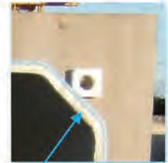
充填後 高弾性接着剤の充填部 (内目地)
