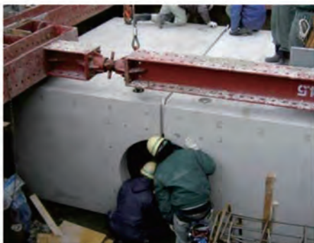
開口部の接続状況
