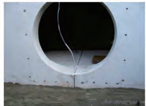
開口部の注入状況
